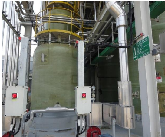
图 3.5.2-6 污水处理站总排口
