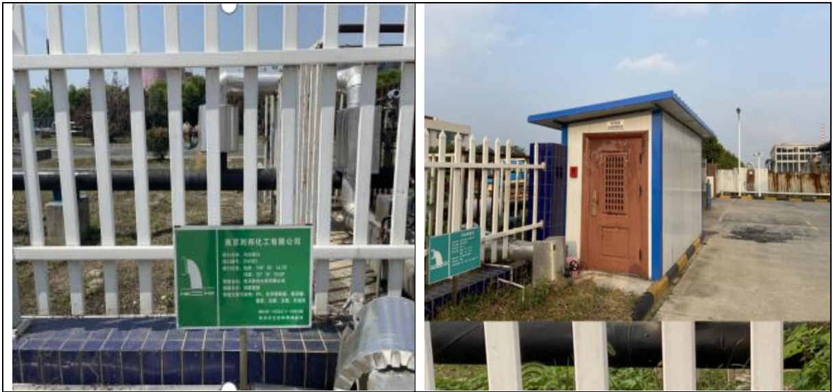
污水排口及在线监测
