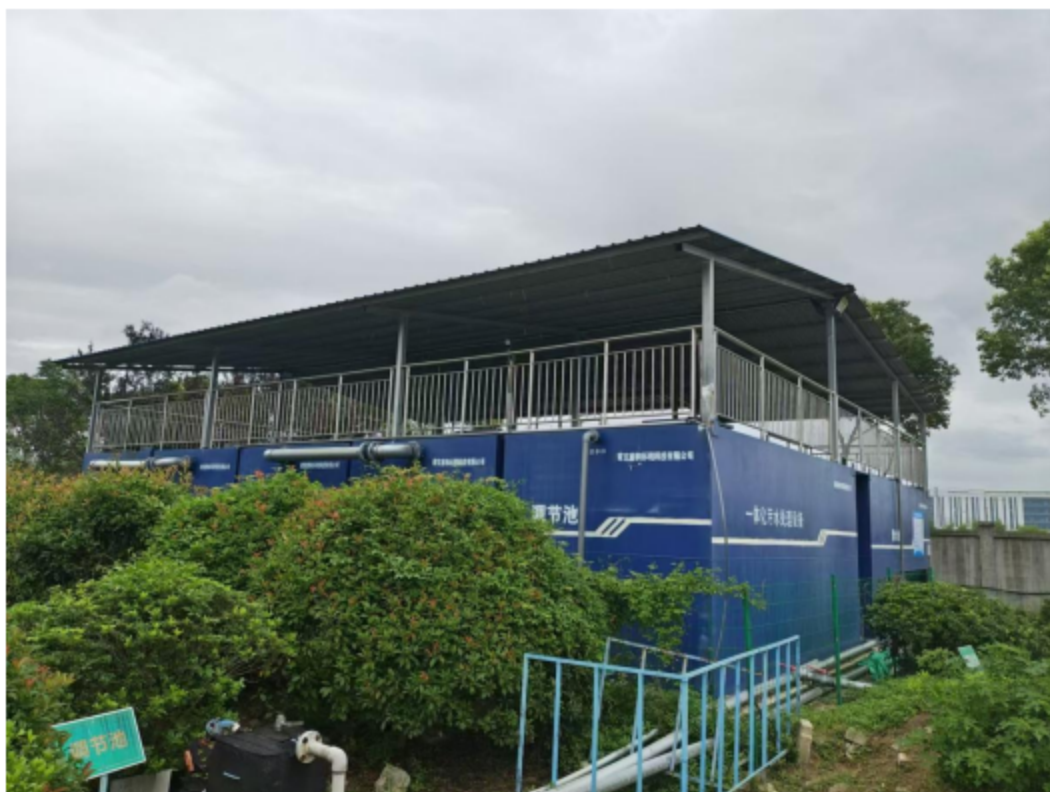
图 2-16 现有污水预处理装置图
