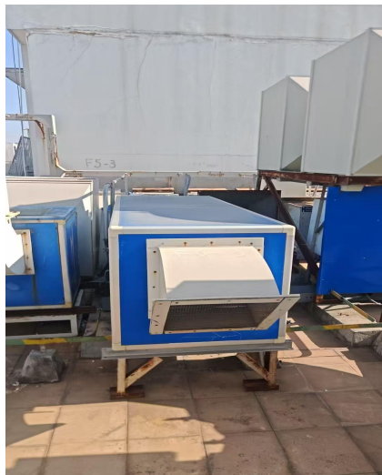
图 2-4 楼顶废气处理装置
