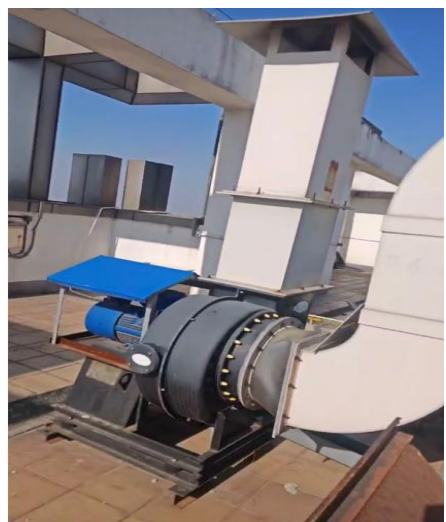
图 2-4 楼顶废气处理装置
