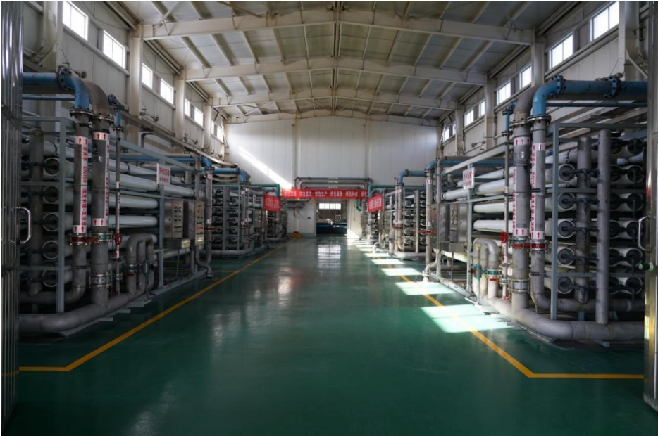
图 7.3.3-2 反渗透单元
