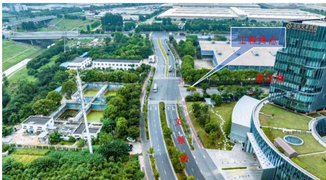
图 3-6 工程终点文景路现状航拍图
